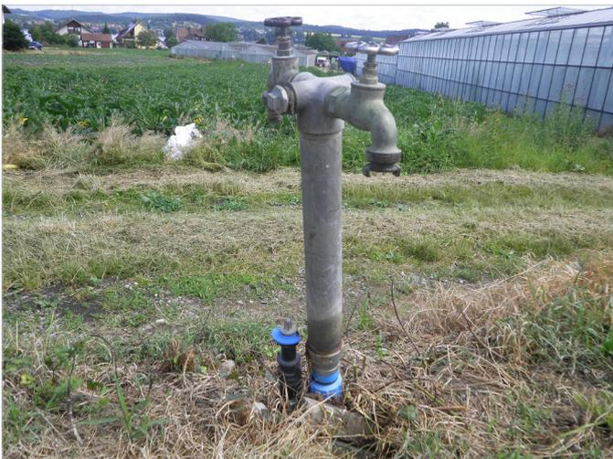
Der untere Abgang ist, passend zu den vorhandenen Unterflurhydranten, mit einem Flansch DN 80 ausgestattet, so dass der Austausch schnell und einfach erfolgen kann.
