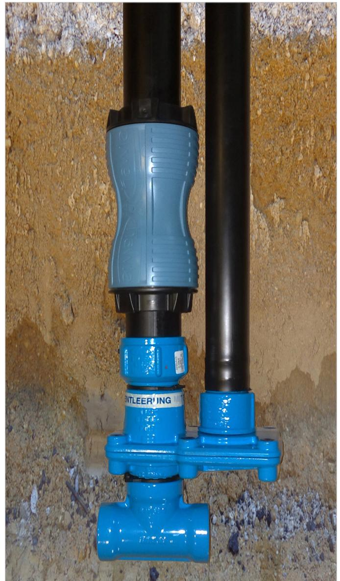
Der Hawle-Bewässerungshydrant „Typ Reichenau“ erfüllt sämtliche technischen Anforderungen hinsichtlich der hydraulischen Vorgaben und einer hohen Flexibilität beim Einbau. Darüber hinaus ist die gewählte Lösung aus wirtschaftlicher Betrachtung, unter Berücksichtigung wesentlich geringerer Investitionskosten, gegenüber herkömmlichen Unterflurhydranten hervorzuheben. Eine lange Lebensdauer, begründet durch Materialwahl und ein geringer Wartungsaufwand, zeichnen überdies das Produkt aus.
