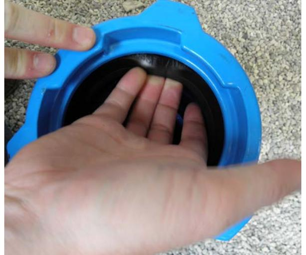
Legen Sie die Dichtung in die BAIO®-Muffe ein.
