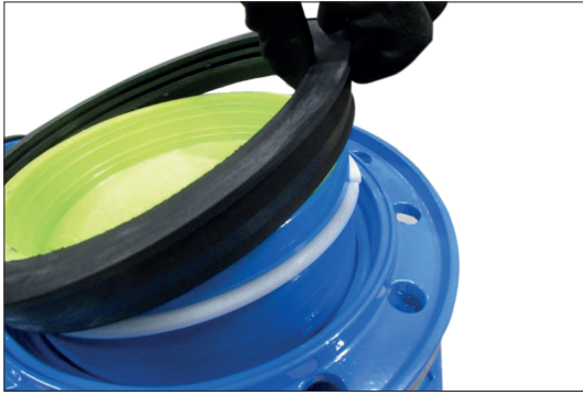
Manschettendichtung abziehen
