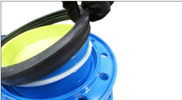
1. Manschettendichtung abziehen
