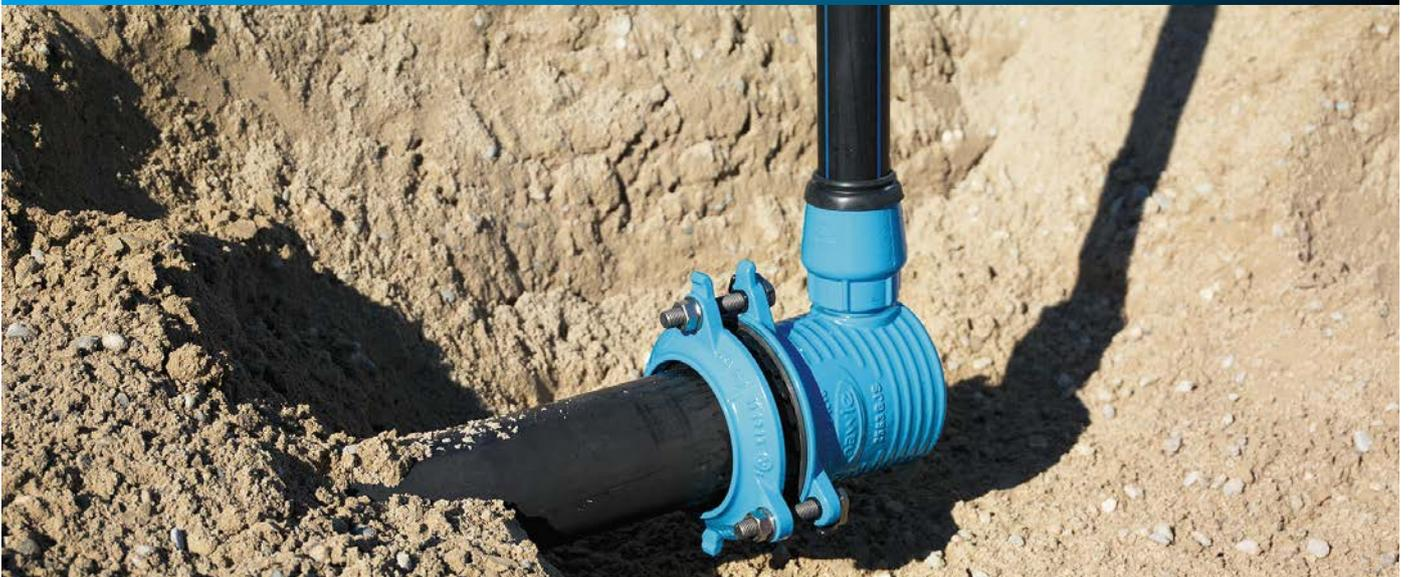
\* Hinweis: Bei Anschluss von PE-Rohren sind immer Hawle-Stützhülsen zu verwenden.
