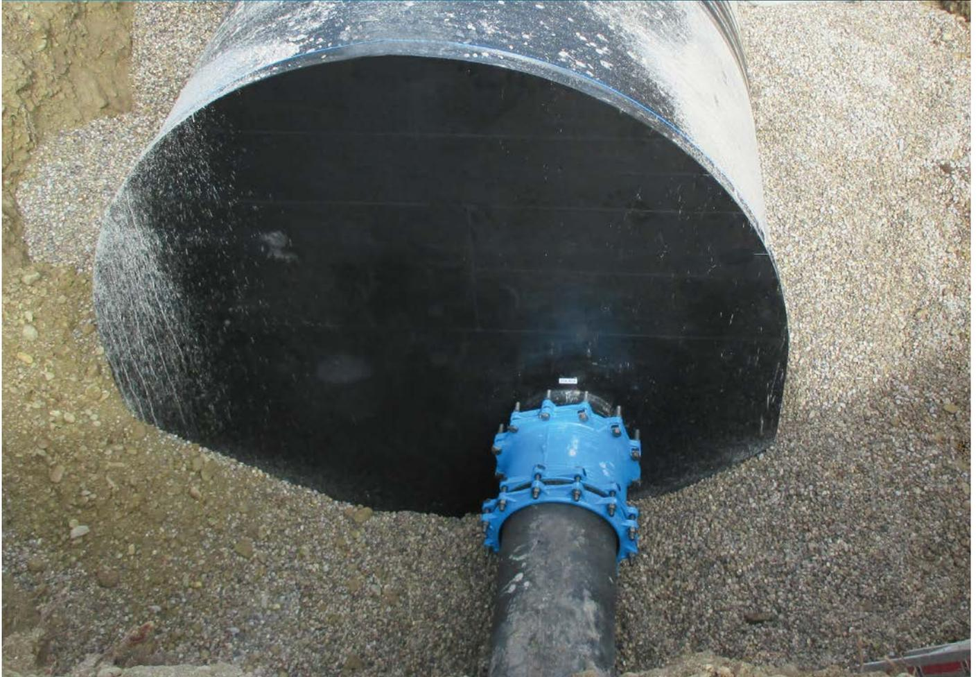
\*Hinweis: Bei Anschluss von PE-Rohren sind immer Hawle-Stützhülsen zu verwenden, keine zugfeste Verbindung mit AZ-Rohren.
