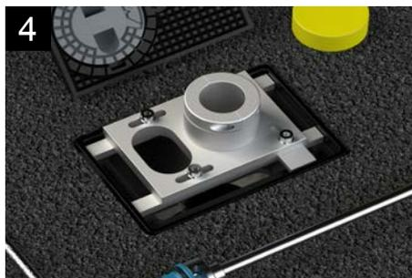
4 Spanneinheit in den Kappenrahmen einlegen und mittig über dem Standrohr positionieren.
