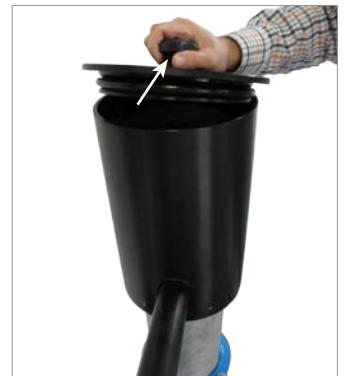
12. Deckel der Überflutungssicherung montieren und mit Hilfe der Spannschraube fixieren.
