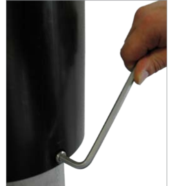
8. Überflutungssicherung mit Innensechskantschlüssel fixieren.
