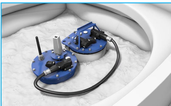
Erdreich auffüllen und verdichten (bis ca. 10 cm unter Antriebsdeckel)
