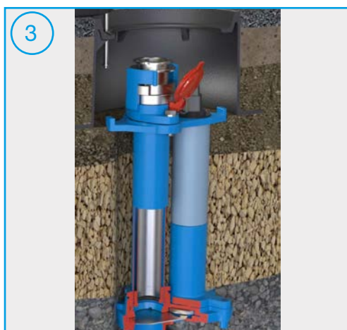
Aufsetzen und Verspannen des Abdruckflansches
