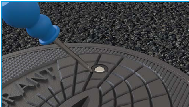
Schmutzdichtung entfernen.
